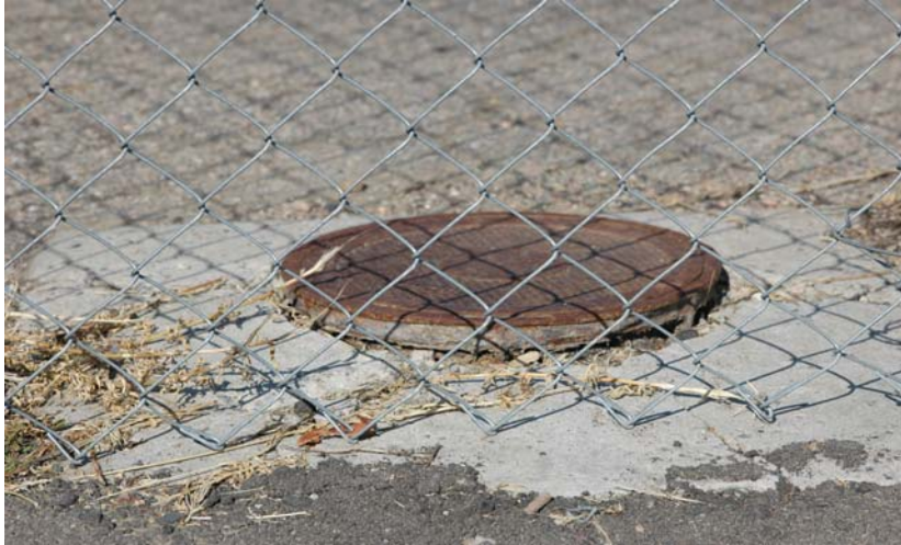
5.5.1. Broken concrete.
